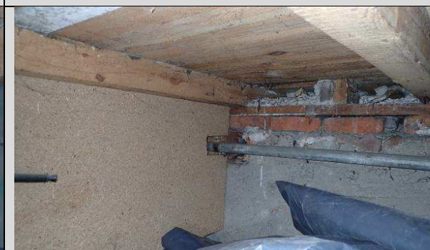
Fot. W_52, W_53. Konstrukcja sceny drewniana. Pod sceną widoczna murowana konstrukcja podpiwniczenia.
