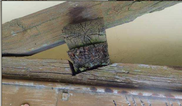
Fot. Z_24, Z_49, Z_50, Z_52. Obserwowana korozja biologiczna elementów więźby dachowej sytuowanych „na zewnątrz” obiektu.
