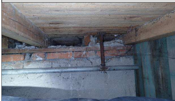
Fot. W_52, W_53. Konstrukcja sceny drewniana. Pod sceną widoczna murowana konstrukcja podpiwniczenia.
