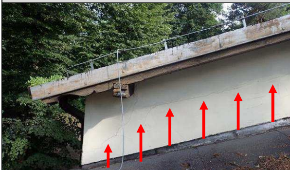
Fot. Z_41, Z_42. Obserwowane zarysowania okładziny supremy mogące świadczyć o zaistniałym przemieszczeniu elementów konstrukcyjnych.
