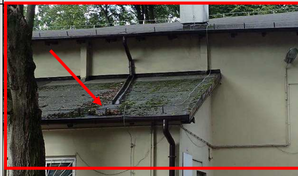
Fot.Z_9. Sposób odprowadzenia wody opadowej prowokujący „przelewanie” wody przez okap.
