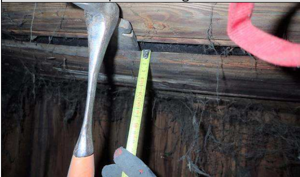
Fot. P_30. Deskowanie wykonane z desek gr. 16mm.
