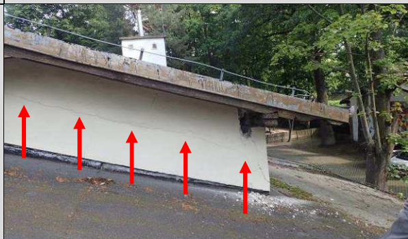
Fot. Z_41, Z_42. Obserwowane zarysowania okładziny supremy mogące świadczyć o zaistniałym przemieszczeniu elementów konstrukcyjnych.
