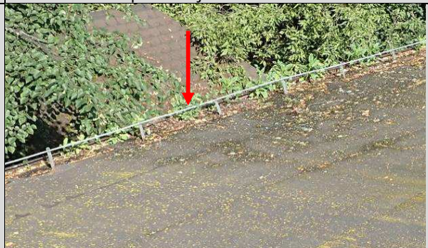
Fot. Z_28. Przykład niedrożnej rynny.
