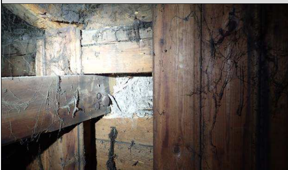
Fot. P_41. Widok fragmentu płyty suprema (ocieplenie elewacji).
