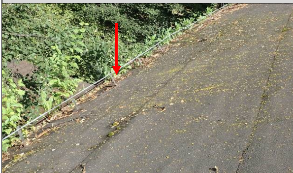
Fot. Z_30. Przykład niedrożnej rynny.
