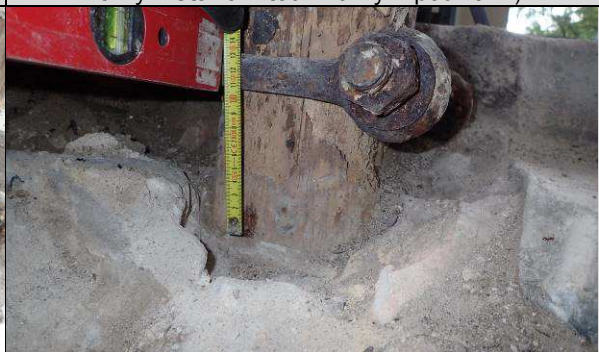
Fot. 03_9, 03_10. Podstawa słupów zabetonowana na głębokości ok. 11cm poniżej poziomu terenu.
