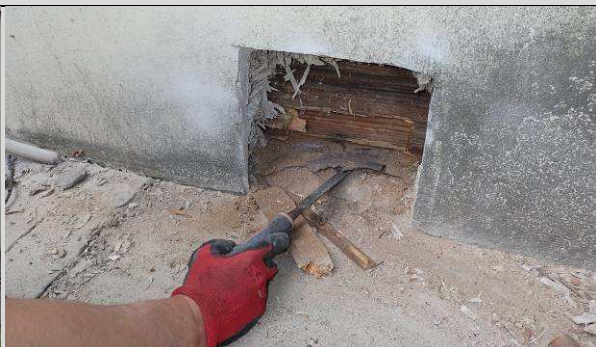
Fot. O5_4. Belka podwalinowa ułożona powyżej poziomu terenu, na przekładce z papy.
