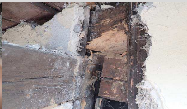
Fot. 02_7. Widoczna korozja biologiczna elementów konstrukcyjnych.
