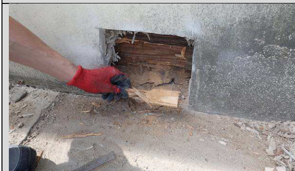
Fot. O5_5, O5_7. Podwalina w średnim stanie technicznym. Brak jest jeszcze widocznych deformacji świadczących o jej przeciążeniu, ale obserwuje się już zaawansowane ubytki przekroju spowodowane żerowaniem larw owadów.
