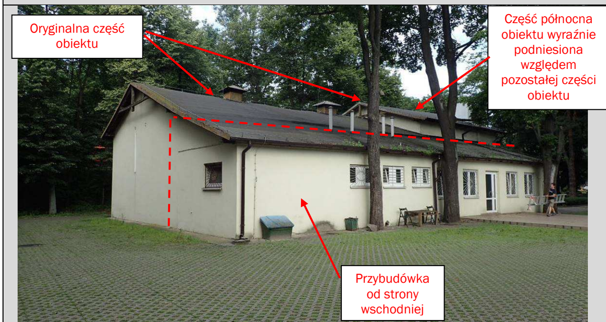
Fot. Z_1. Budynek parterowy z przybudówką. Część północna dachu wyraźnie podniesiona względem pozostałej części obiektu.
