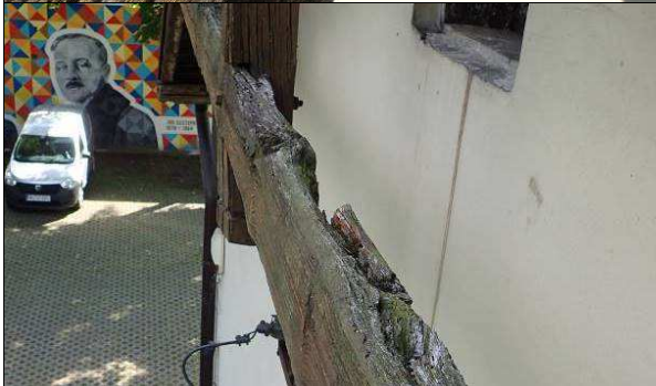
Fot. Z_24, Z_49, Z_50, Z_52. Obserwowana korozja biologiczna elementów więźby dachowej sytuowanych „na zewnątrz” obiektu.
