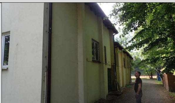
Fot. Z_14. Na elewacji zachodniej w osiach wiązarów pełnych widoczne pilastry, świadczące o obecności słupów zewnętrznych.
