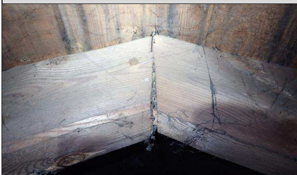
Fot. P_8. Obserwowany „obrót krokwi” w węźle kalenicowym (dotyczy wszystkich krokwi za wyjątkiem krokwi w wiązarach pełnych).
