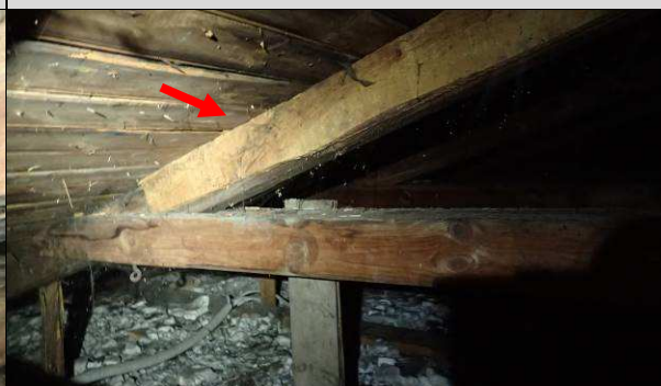
Fot. P_85. Na jednej z krokwi widoczne lokalne wzmocnienie nakładkowe z deski.
