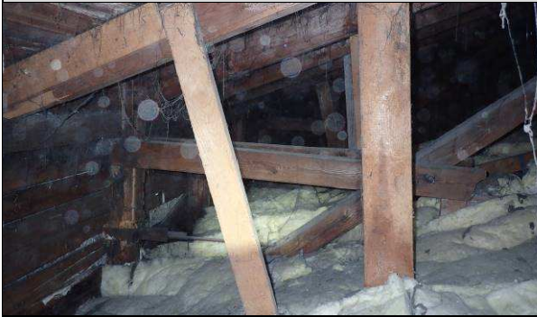
Fot. P_20. Obserwowane wtórne elementy konstrukcyjne, stanowiące wieszaki sufitu podwieszanego.
