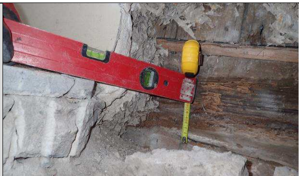
Fot. 03_2, 03_6. Belka podwalinowa 8cm poniżej poziomu terenu. Fakt ten świadczy o wykonanych w przeszłości pracach związanych z podniesieniem terenu przy budynku.
