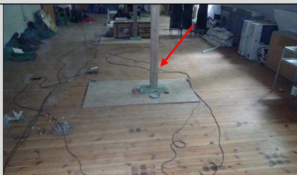
Fot. W_15, W_16. Widoczny fragment zabezpieczenia wykonanego w ramach opracowania [7, 8]. Tu podpora kalenicy obiektu.
