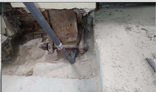
Fot. 03_11 ,03_12. Obejma spinająca dostawione słupy z pierwotną konstrukcją poluzowana, niespełniająca swojej funkcji.
