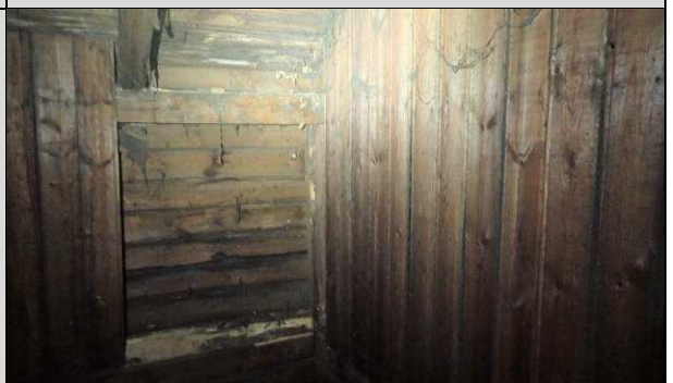
Fot. P_47. Widok oryginalnej elewacji obiektu – drewniana z desek w układzie poziomym.
