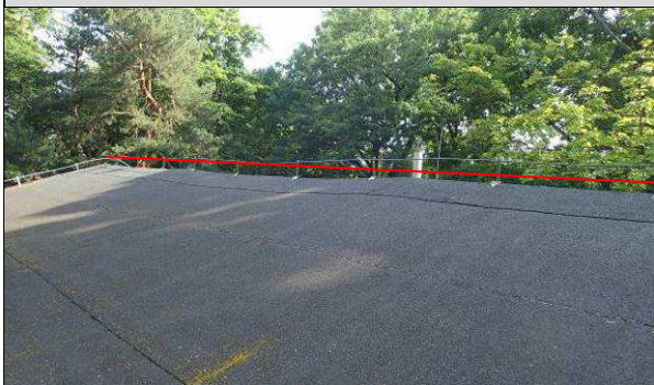
Fot. Z_45, Z_54. Linia kalenicy „pofalowana”. „Górki” zlokalizowane są na więzarach pełnych, a „dołki” na krokwiach pośrednich. Jest to deformacja powstała podczas użytkowania obiektu.
