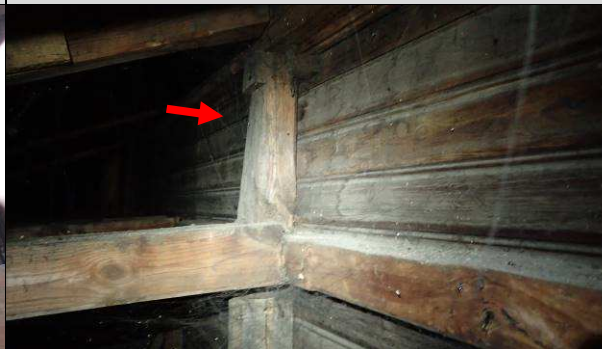
Fot. P_69. Na słupie widoczne złącze ciesielskie, świadczące o obecności w tym miejscu elewacji jakiegoś dawnego elementu architektonicznego (najprawdopodobniej daszka bądź ganku). W bezpośredniej okolicy ww słupa krokwie obcięte na równo z elewacją.
