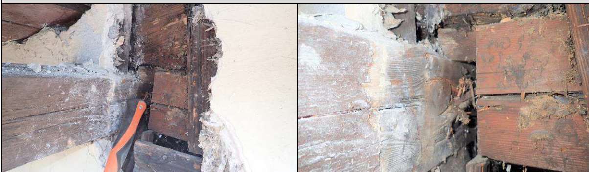
Fot. 02_3, 02_5. Stwierdzono przemieszczenie elementów konstrukcyjnych. Na dolnym elemencie widoczne przeciążenie elementu przez docisk.
