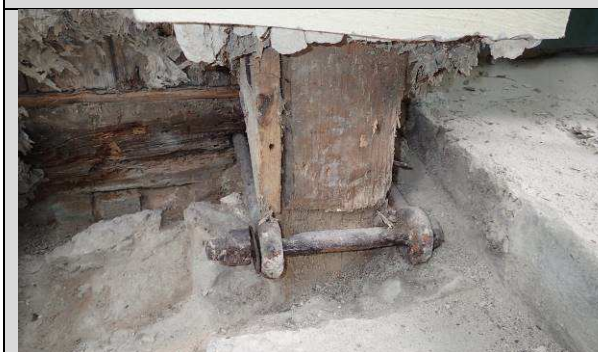
Fot. 03_11 ,03_12. Obejma spinająca dostawione słupy z pierwotną konstrukcją poluzowana, niespełniająca swojej funkcji.
