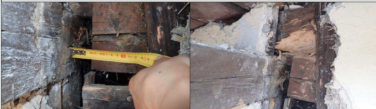
Fot. 02_7. Widoczna korozja biologiczna elementów konstrukcyjnych.
