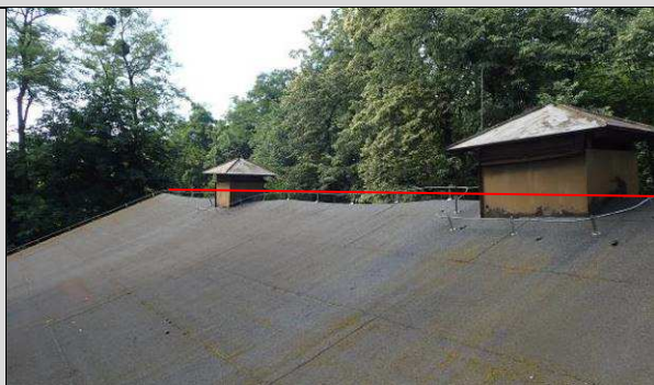
Fot. Z_45, Z_54. Linia kalenicy „pofalowana”. „Górki” zlokalizowane są na więzarach pełnych, a „dołki” na krokwiach pośrednich. Jest to deformacja powstała podczas użytkowania obiektu.
