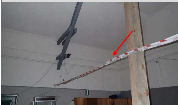
Fot. W_25. Widoczny fragment zabezpieczenia wykonanego w ramach opracowania [7, 8]. Tu ściąg tymczasowy.
