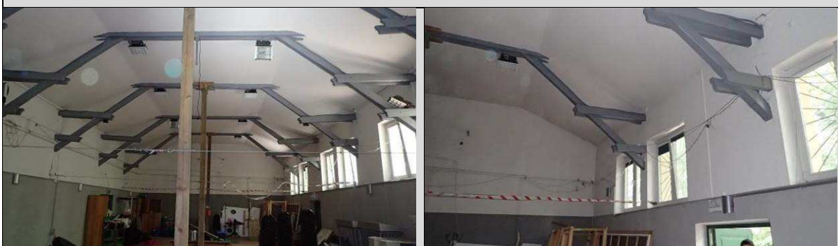
Fot. W_1, W_23. Część elementów konstrukcyjnych więźby dachowej widoczna. Na wysokości jętek wykonany podwieszany sufit z płyt g-k.
