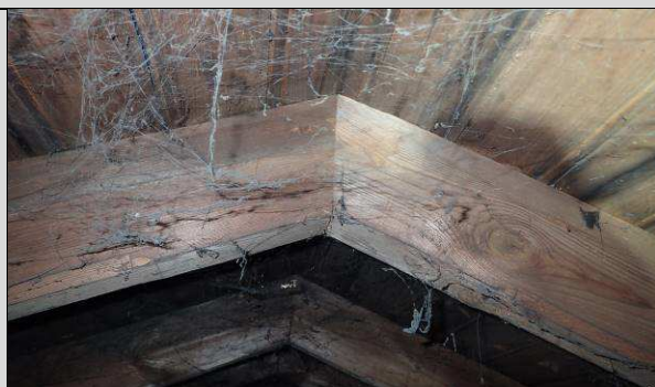
Fot. P_6. Krokwie w wiązarach pełnych bez obserwowanego „obrotu” w węźle kalenicowym.
