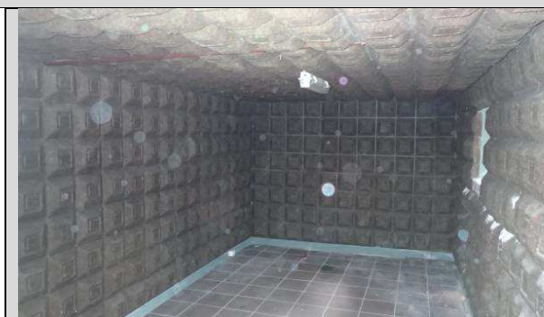
Fot. W_55. Jedno z pomieszczeń piwnicznych (obecnie puste) wygłuszone przy pomocy mat z wełny mineralnej, na wzór pomieszczeń studyjnych.
