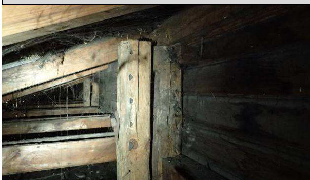
Fot. P_75. Wieżba dachowa części dobudowanej w konstrukcji dachu drewnianego jednospadowego. Wieżba dachowa części dobudowanej oparta na dodanych elementach konstrukcyjnych, ale trwale zespolonych z pierwotną częścią obiektu.
