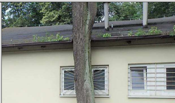
Fot. Z_5. Roślinność porastająca rynny.
