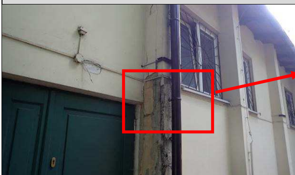
Fot. Z_15. Powierzchnia elewacji ocieplona przy pomocy płyt suprema oraz wykończona przy użyciu tynku cienkowarstwowego.
