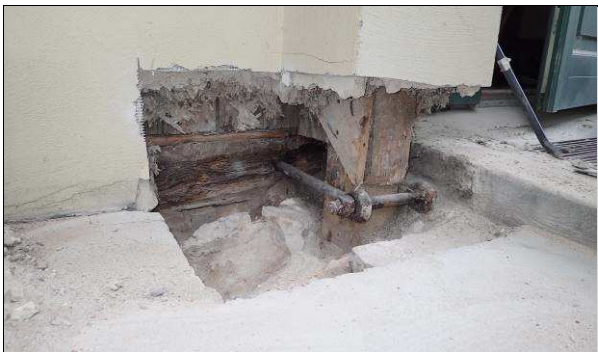
Fot. 03_2, 03_6. Belka podwalinowa 8cm poniżej poziomu terenu. Fakt ten świadczy o wykonanych w przeszłości pracach związanych z podniesieniem terenu przy budynku.
