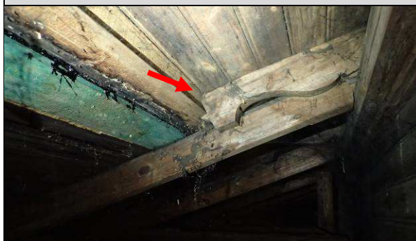
Fot. P_77. Przykład oryginalnej ozdobnej krokwi.
