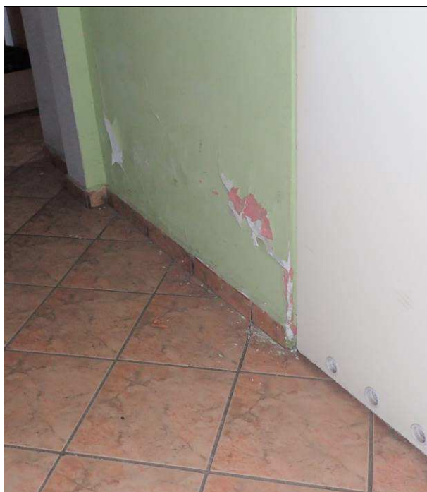
Fot. W_48. Przykładowe odparzenie warstw malarskich w strefie cokołowej.
