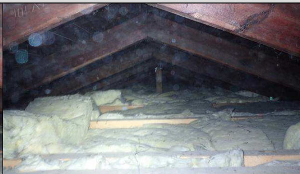
Fot. P_54, P_55. Widok poddasza części niższej (nad częścią główną sali). Widoczne „nowe” (nieoryginalne) jętki mocowane w osi każdej krokwi. W węzłach kalenicowych widoczne oznaki obrotu krokwi, analogicznego jak w części wyższej.
