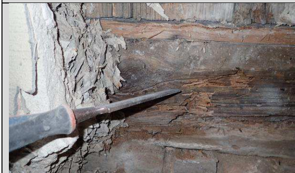
Fot. 03_14. Oryginalny fundament obiektu murowany z cegły pełnej. Między podwaliną a fundamentem brak jakiegokolwiek przekładki izolacyjnej. Belka podwalinowa w złym stanie technicznym.
