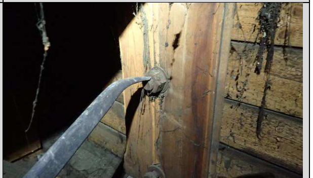
Fot. P_36. Śruby zespalające słupy wielogłęziowe sytuowane w osiach wiązarów głównych.
