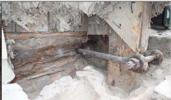
Fot. 03_3. Widoczny „podwójny” słup konstrukcyjny dostawiony przed licem elewacji – dowód wykonanych w przeszłości prac wzmacniających (najprawdopodobniej w związku ze złym stanem technicznym podwalin).
