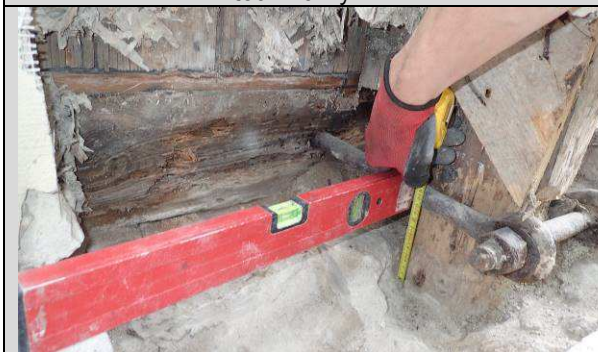
Fot. 03_9, 03_10. Podstawa słupów zabetonowana na głębokości ok. 11cm poniżej poziomu terenu.
