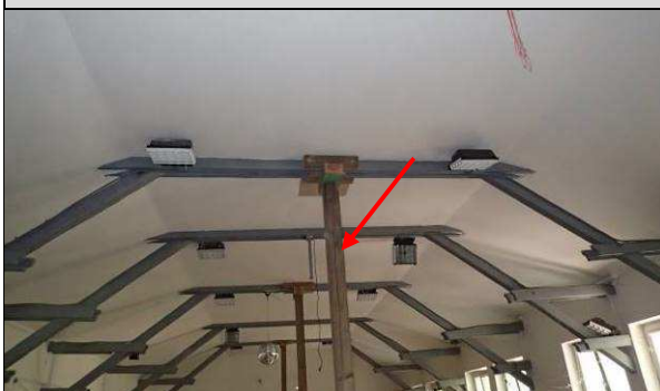
Fot. W_15, W_16. Widoczny fragment zabezpieczenia wykonanego w ramach opracowania [7, 8]. Tu podpora kalenicy obiektu.
